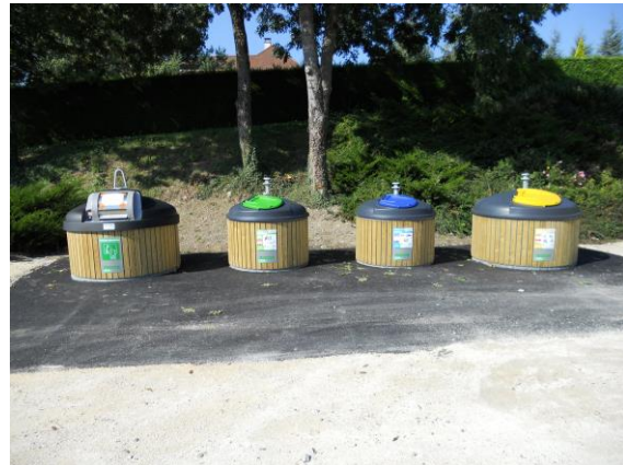
PAV avec conteneurs semi-enterrés
