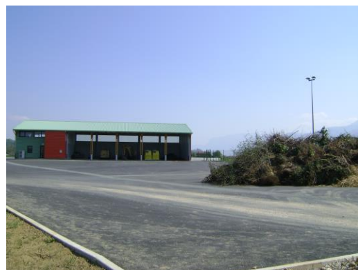
Plate-forme de broyage des déchets verts
