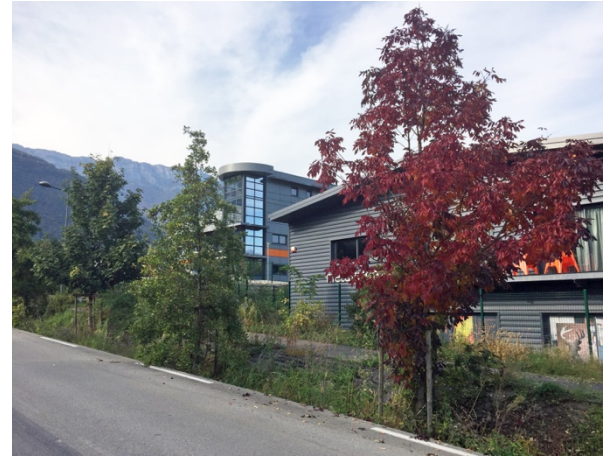
Une noue qui récupère les eaux pluviales – Eurékalp – Saint-Vincent-de-Mercuze
