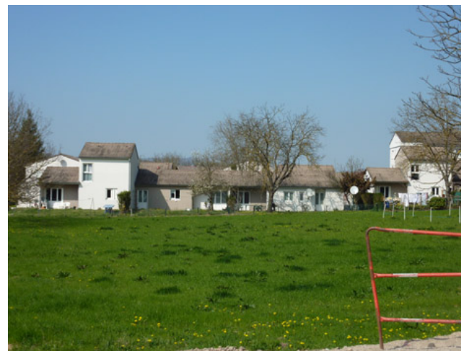
Les HLM du village : opération mixte logement collectif et maisons groupées
