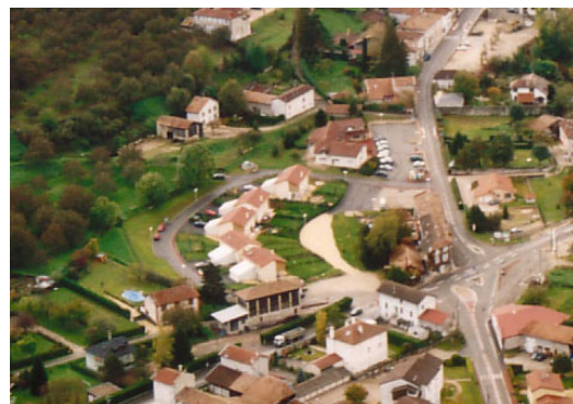
Résidence les Lavandières : 5 villas jumelées réalisées par l'OPALE en 2001
